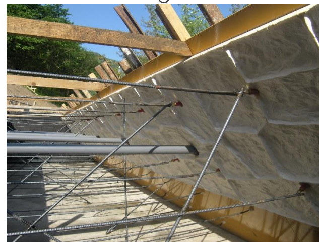
<化粧型枠 (施工)>
