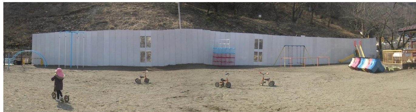
<クリアパネルの一部使用による現場の可視化>
