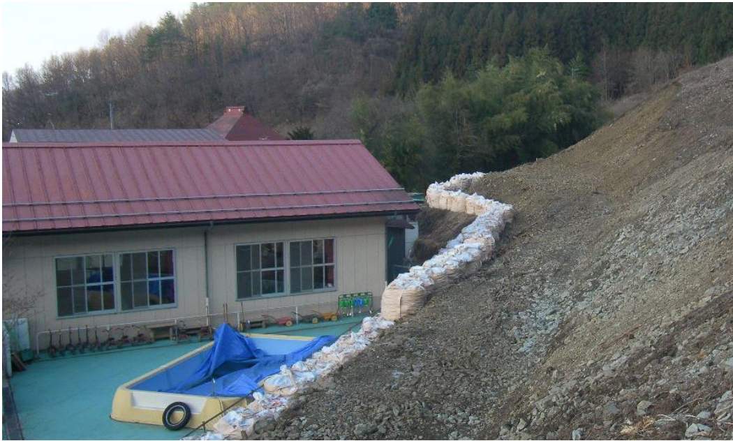
<大型土のう設置>
