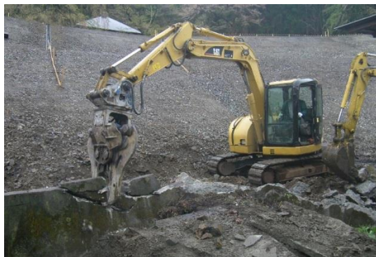
<油圧圧砕機の使用>
