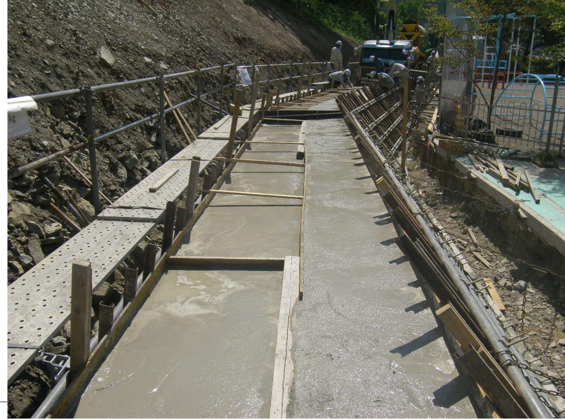
< コンクリート打設完了 (下層) >
