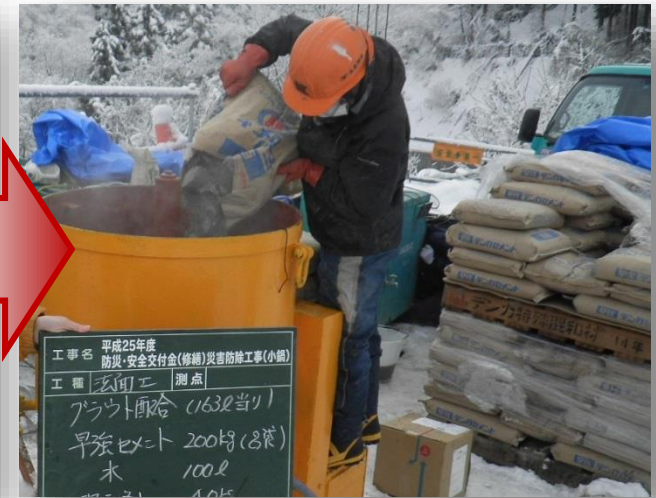
<グラウト製造> (普通セメント) (早強セメント)
