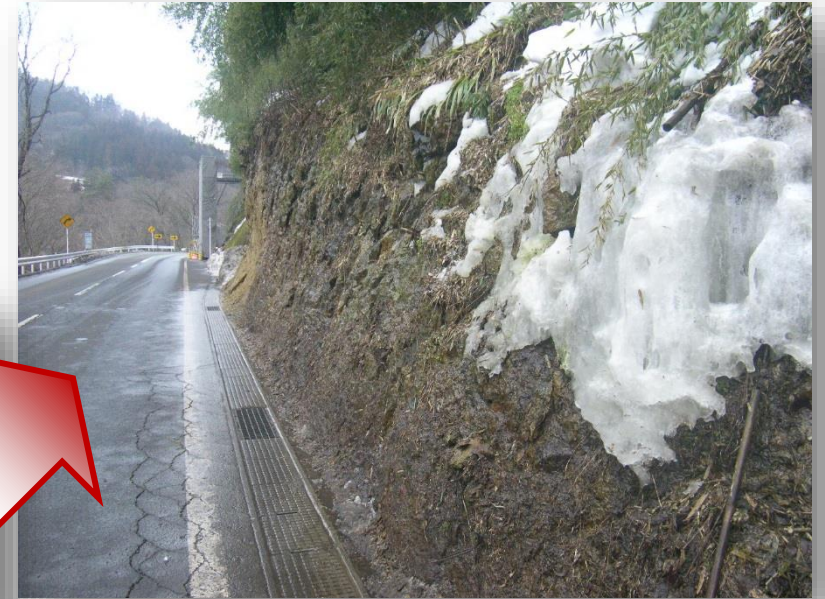
< 落石除去完了 >
