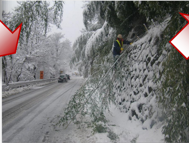
< 倒木撤去状況 >
