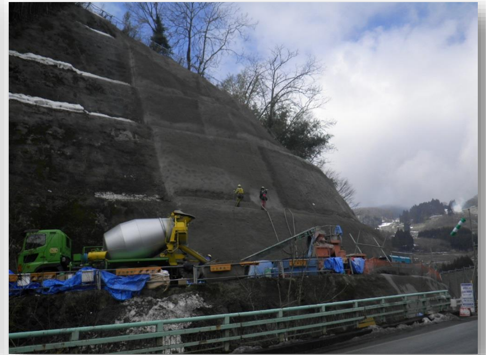
＜モルタル吹付状況＞ (H27.3月上旬)
