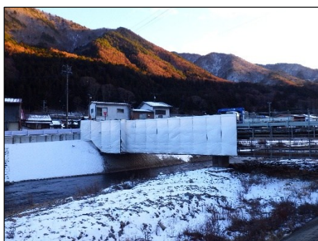
冬季中の吊足場
